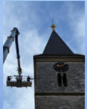
Dank moderner Technik - einer Hebebühne am ausfahrbaren Arm eines Lastwagens - konnten die Arbeiten schnell und sicher durchgeführt werden. Besonders bei stürmischem Wetter wird man den Unterschied deutlich merken: Das lästige Klappern loser Schindeln gehört nun der Vergangenheit an.
